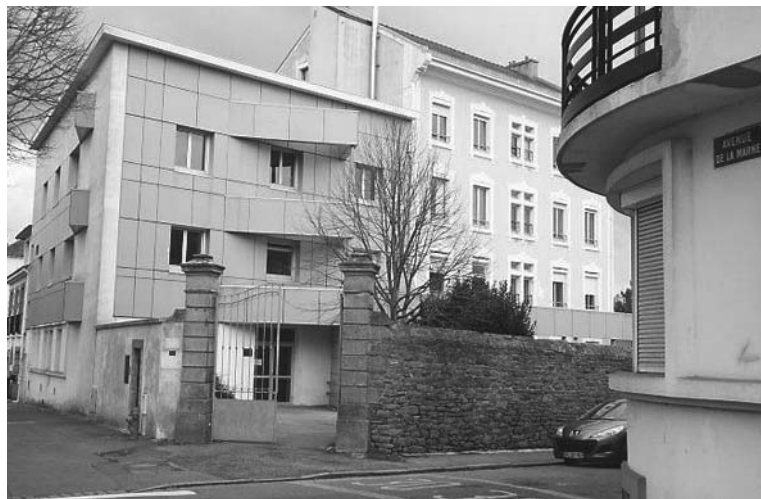
Foyer de Vannes
